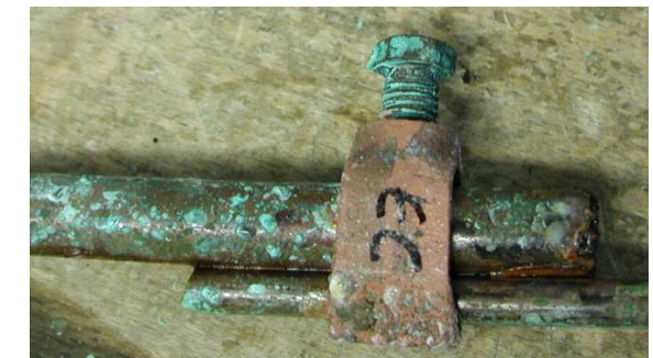
Κατάλληλο, μόνο επιφανειακή οξείδωση του Cu – όχι διάβρωση
