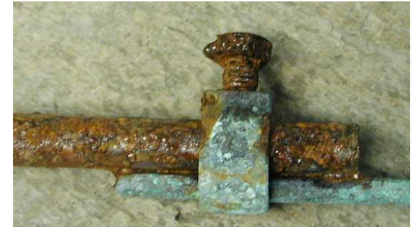
Ακατάλληλο λόγω έντονης διάβρωσης της χαλύβδινης ψυχής
